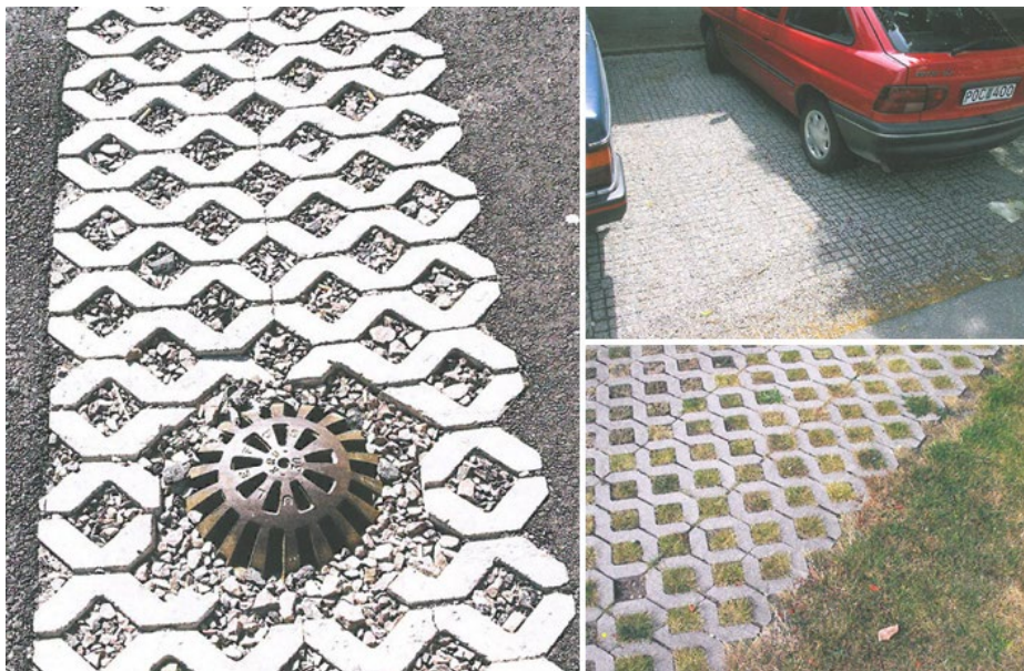
Figur 50 visar ett antal exempel på ytor som inte ska räknas som hårdgjorda ytor.
